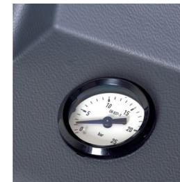
Dank des Manometers für die Anzeige des internen Kältemittelflaschendrucks ist eine zusätzliche Kontrolle möglich.
